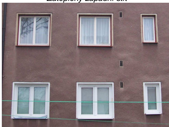
Okna původní dřevěná a nová plastová
